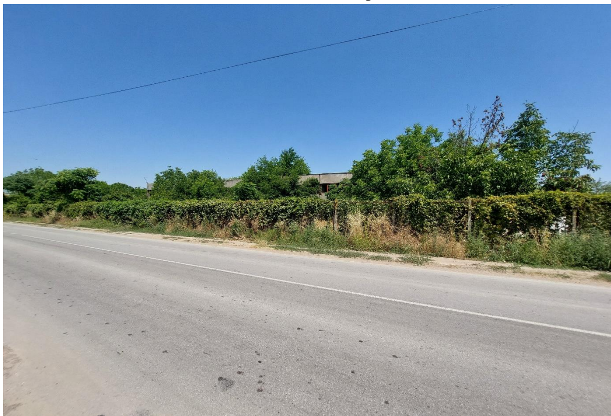
Снимка 14. Обезманганителна станция, с. Вардим
